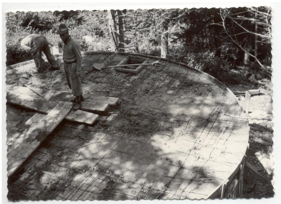
Getto del solaio di copertura
