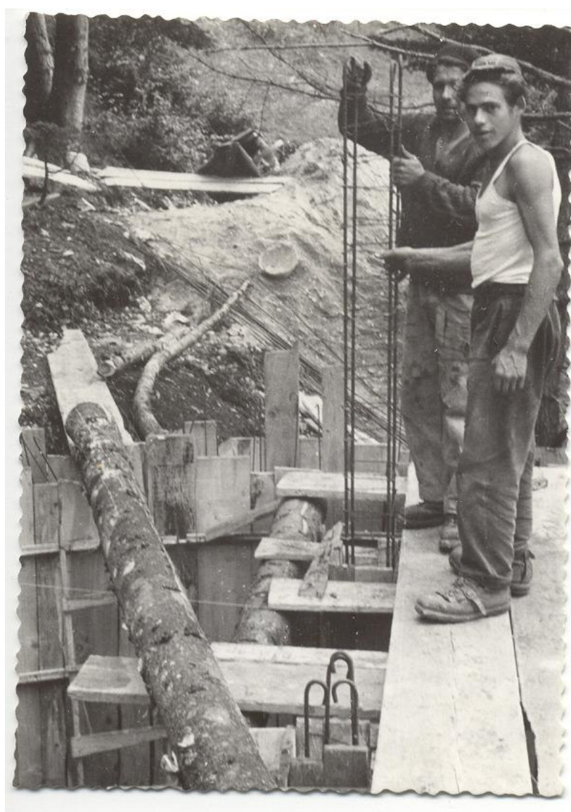
Armatura pilastri
