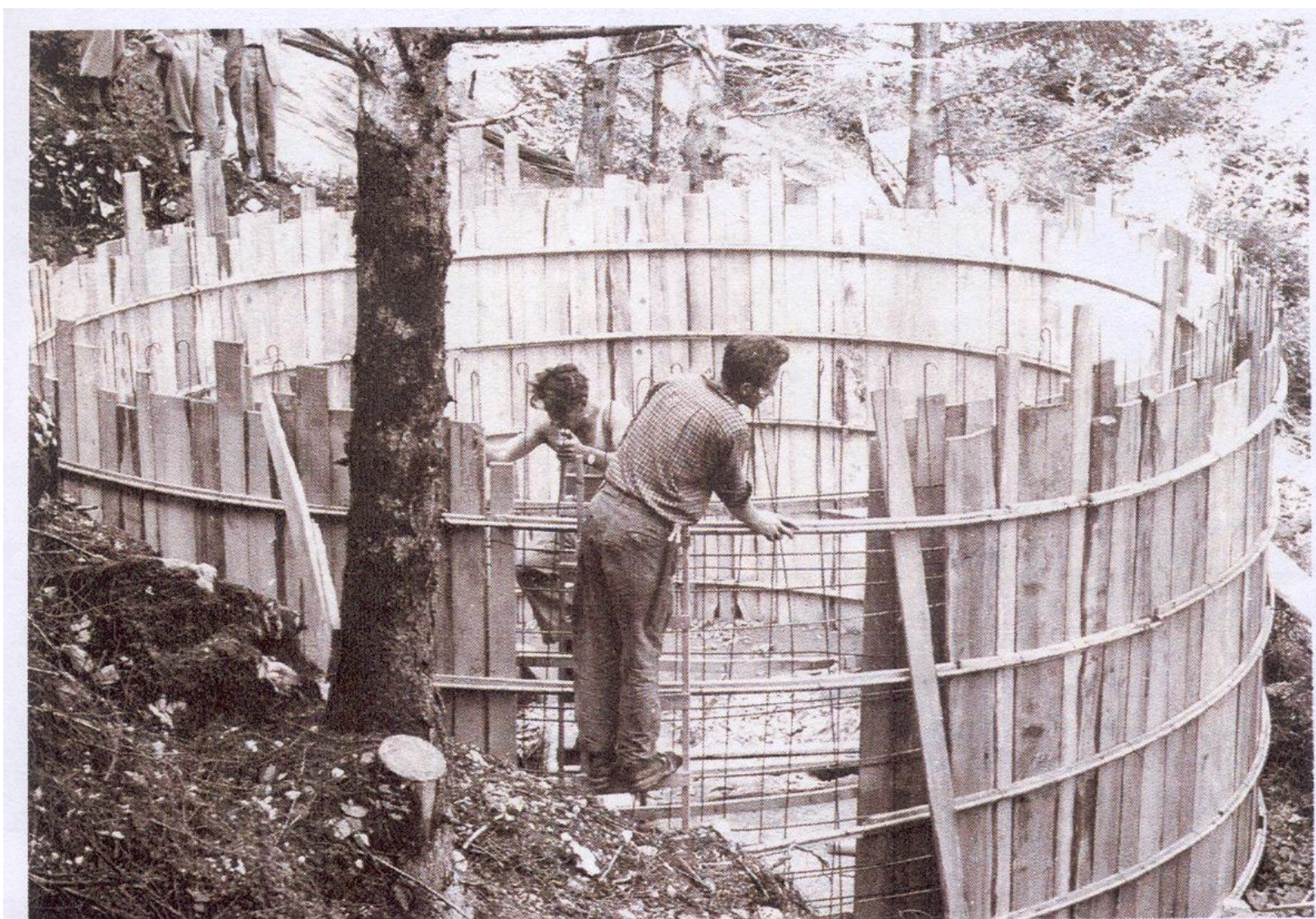
Fasi di casseratura ed armatura delle pareti verticali della vasca
