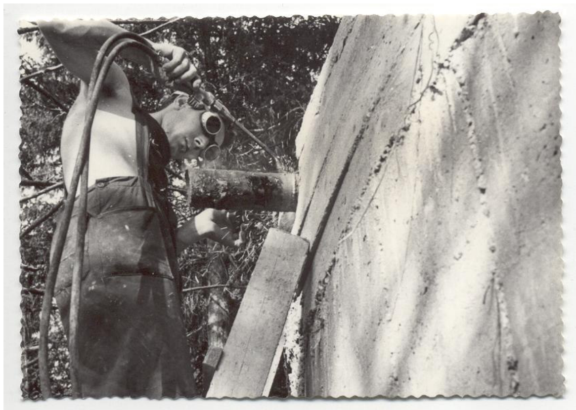
Particolare realizzazione del “troppo pieno”
