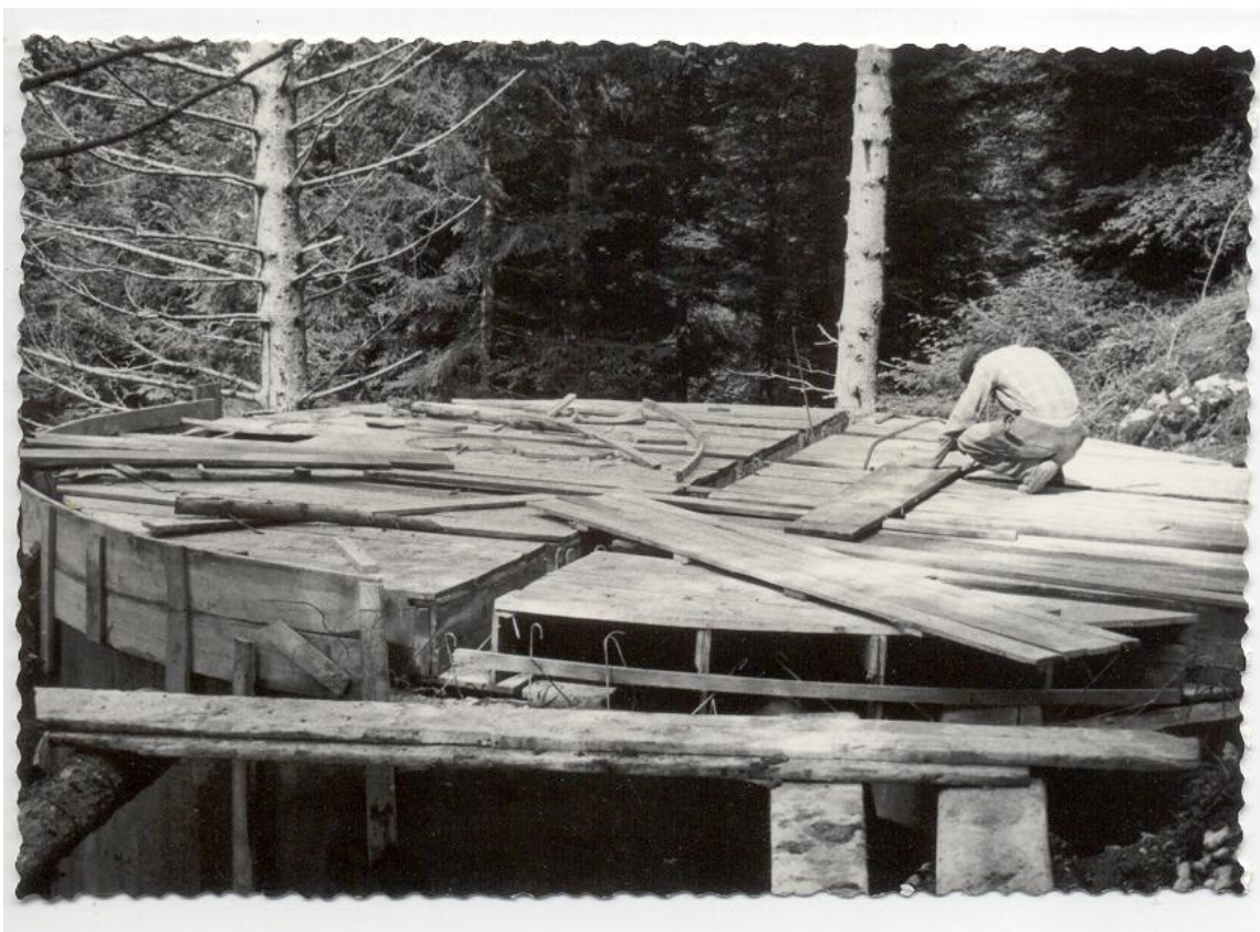
Armatura del solaio di copertura
