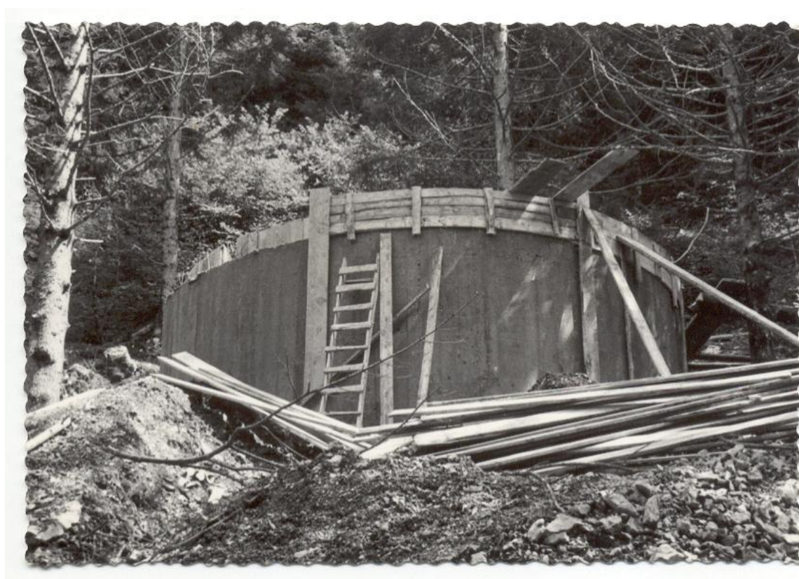
Disarmo delle pareti verticali
